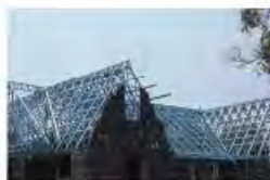
Строительство мансардных этажей
