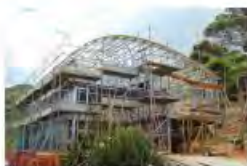
Строительство коммерческой недвижимости
